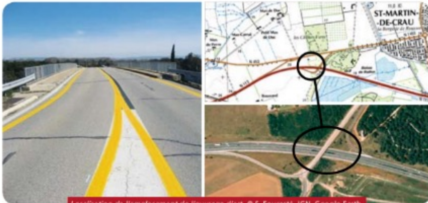
Localisation de l'emplacement de l'ouvrage d'art. © S. Fourasté, IGN, Google Earth
